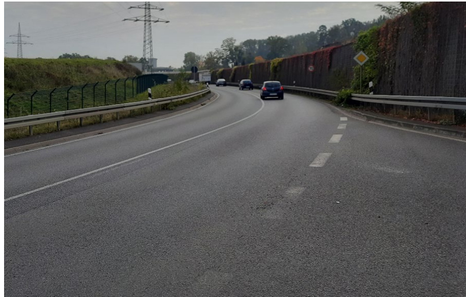
Abbildung 7-3: Netzlücke an der südlichen K92
