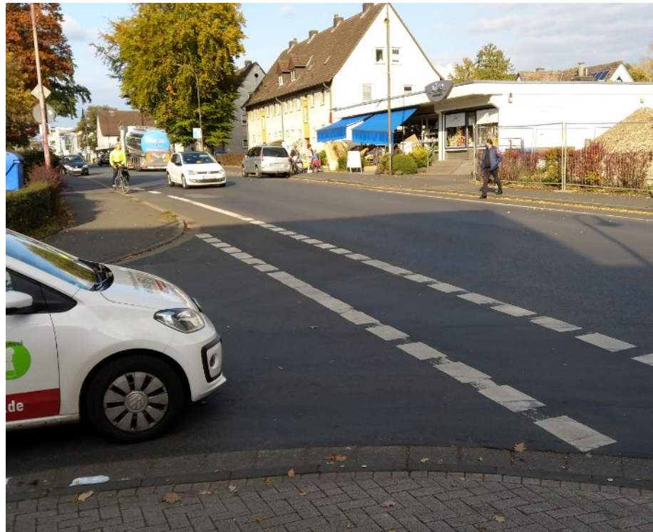
Abbildung 7-19: Bestandsanlagen auf der nördlichen Niederkleiner Straße, Abschnitt Mitte
