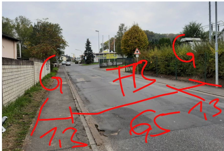
Abbildung 7-6: Gewerbegebietsstraße im DAG-Gebiet ohne Radverkehrsinfrastruktur
