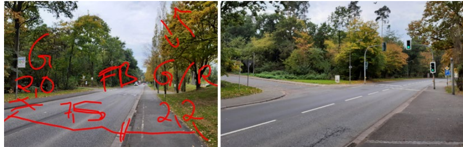
Abbildung 7-9: Bestandsanlagen auf der Waldstraße
