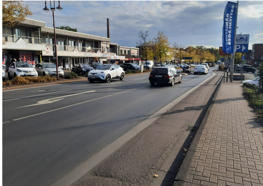
Abbildung 7-21: Bestandsanlagen auf der mittleren Niederkleiner Straße, Abschnitt Nord
