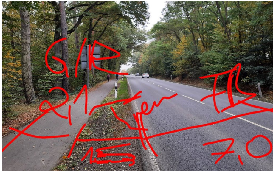
Abbildung 7-25: Bestandsanlagen auf der südlichen Niederkleiner Straße, Abschnitt Süd
