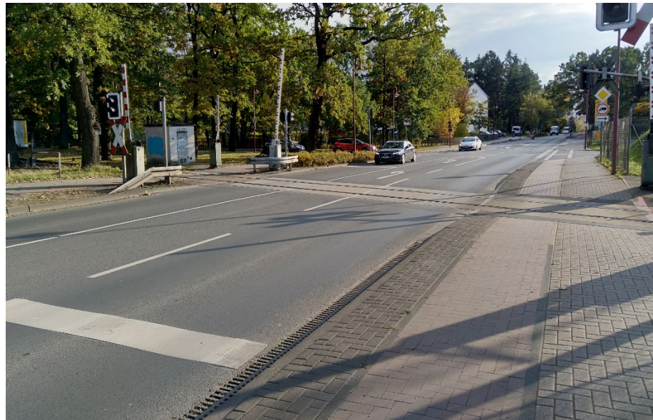
Abbildung 7-22: Bestandsanlagen auf der mittleren Niederkleiner Straße, Abschnitt Süd
