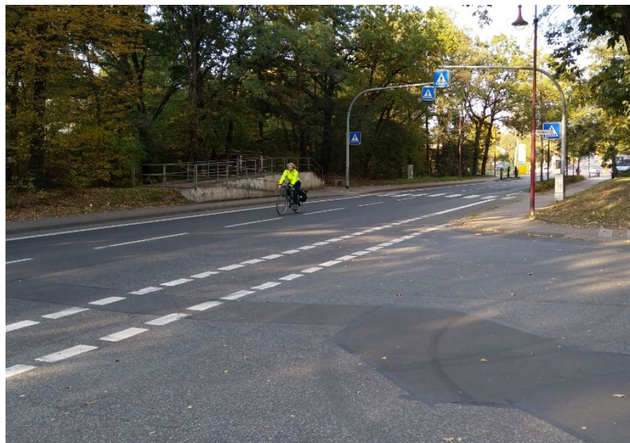
Abbildung 7-23: Bestandsanlagen auf der südlichen Niederkleiner Straße, Abschnitt Nord
