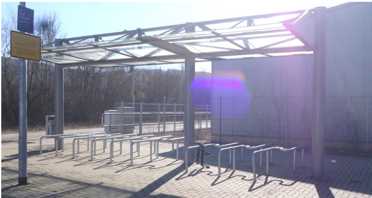
Abbildung 139: Bestandsfoto der B+R-Anlage am Bahnhof Wallau (Lahn) (eigenes Foto (VAR+, 2022))
