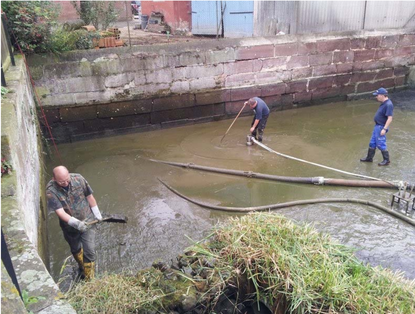
Entschlammten des Feuerlöschteichs 2014
